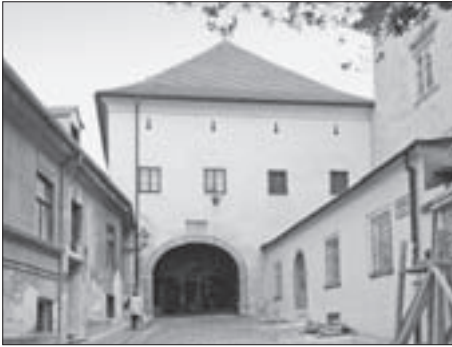
SL. 13. SJEVERNO PROČELJE KAMENITIH VRATA, POGLED IZ RADICEVE ULICE FIG. 13 NORTH FAÇADE OF THE STONE GATE IN RADICEVA STREET
