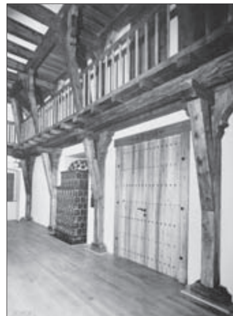
SL. 12. DRVENA KONSTRUKCIJA GALERIJE U GLAVNOJ DVORANI
