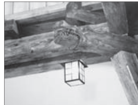
SL. 14. ISTESANI ZAVRŠETCI GREDA U OBLIKU GLAVE ZMAJA U GLAVNOJ DVORANI FIG. 14 MAIN HALL BEAM ENDINGS HEWN IN THE SHAPE OF A DRAGON'S HEAD
