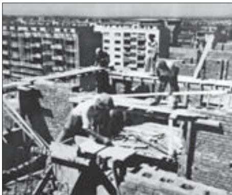
Sl. 3. I. Bartolić, S. Gomboš i V. Hecimović: Izgradnja višestambenih zgrada IV-VIII, južna strana zapadnog dijela Varaždinske ceste (današnje Ulice grada Vukovara), te zgrada IX N. Šegvića, prva zgrada izgrađena uzduž Varaždinske ceste, 1948. U prvom planu radnici na jednoj od zadnjih etaža zgrade IX. (Foto: M. Pavić)
