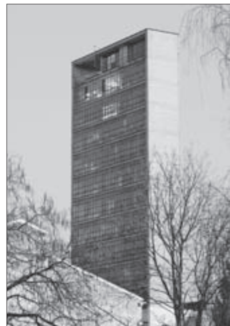
SL. 21. PROBNI TORANJ TVORNIČKE „TEŽ” U ZAGREBU, 2009. FIG. 21 TESTING TOWER, TEŽ FACTORY IN ZAGREB, 2009
