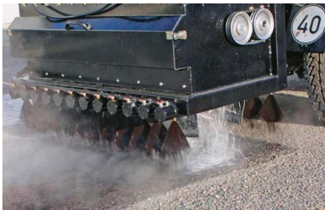
SLIKA 16 – Nanošenje sloja vlakana na asfalt 23
