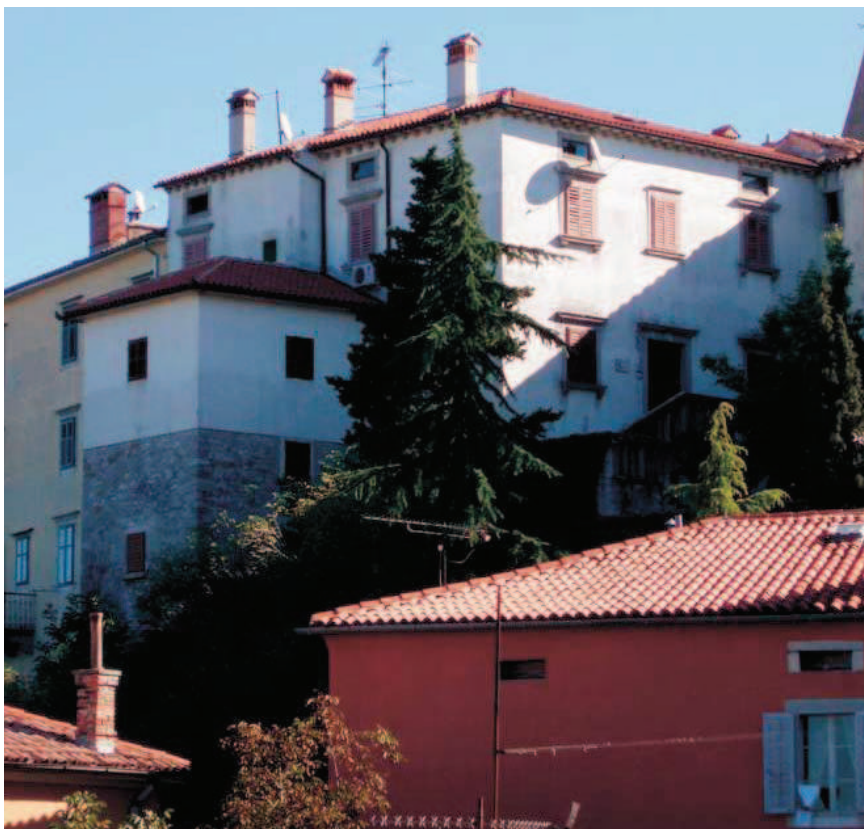
Slika 2. Zgrada Francovich u kojoj je smještena Memorijalna zbirka
