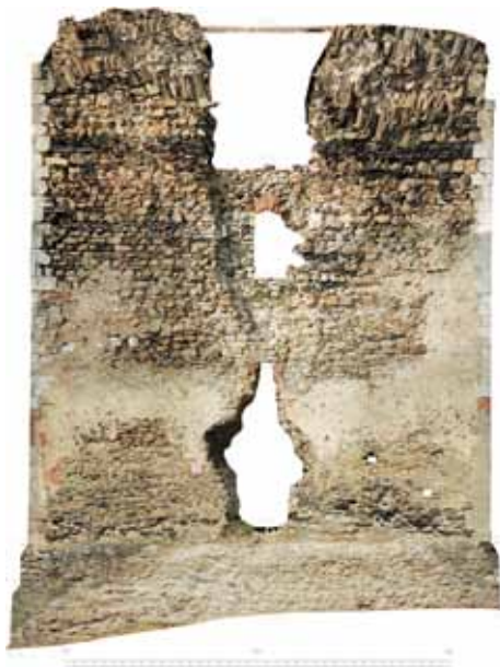
Orto-foto jugozapadnog pročelja središnje kule, Vektra d.o.o., 2010.
