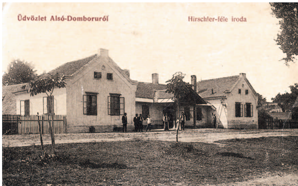
Sl. 16. Upravna zgrada tvrtke za trgovinu drvom Ujlaki - Hirschler i sin u Donjoj Dubravi, izgrađena 1869.
