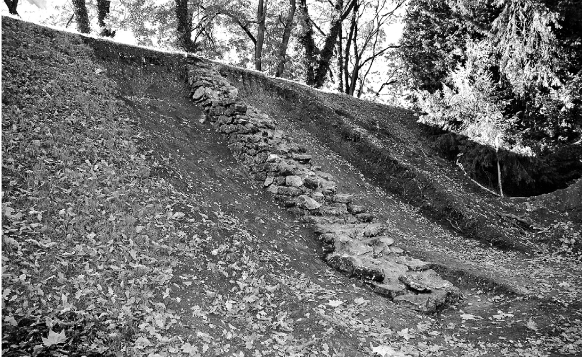
Sl. 7: Južni bedem i ostatak gradskog zida, pogled prema jugozapadu
