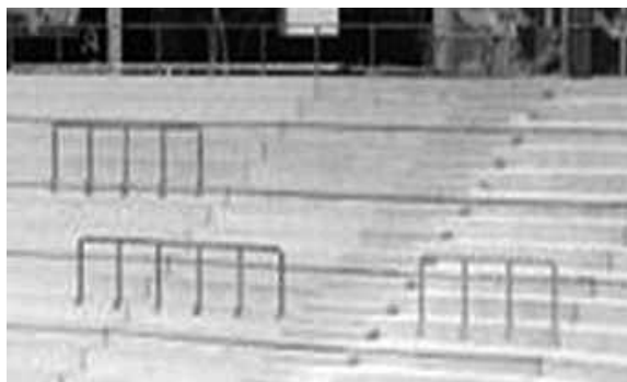
Slika 4: Primjer sigurnosnih prepreka na stajaćim tribinama
