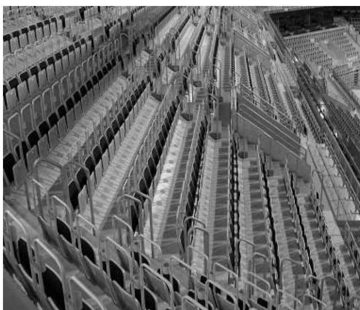
Slika 1: Unutrašnjost SAP Arene (tribine)
