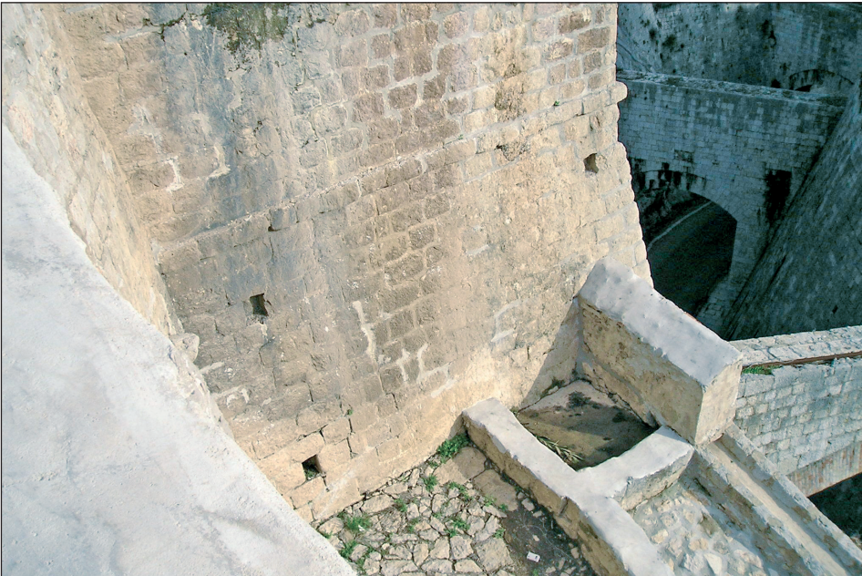
Slika 13. Vidljivi ostatci prvog mlina
