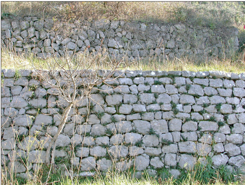
Slika 6. Podzid trase vodovoda
