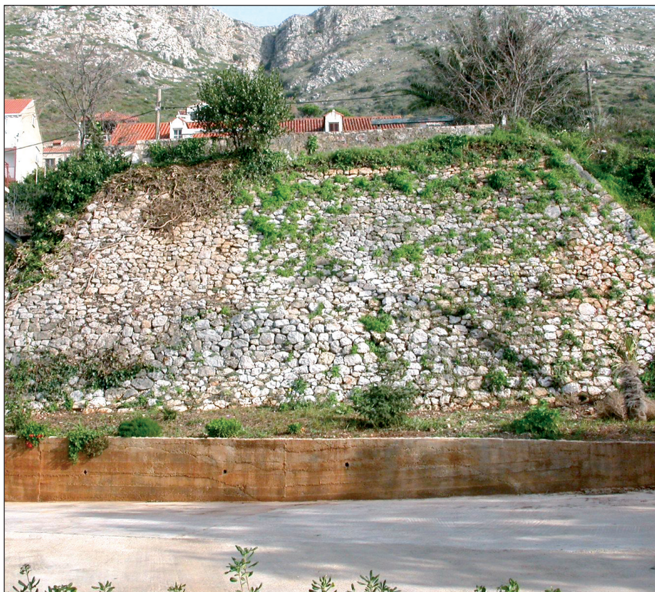
Slika 9. Depozit iznad Gruža
