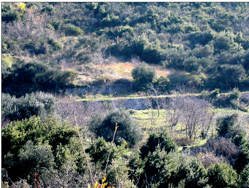
Slika 5. Početni dio trase vodovoda na flišnoj podlozi
