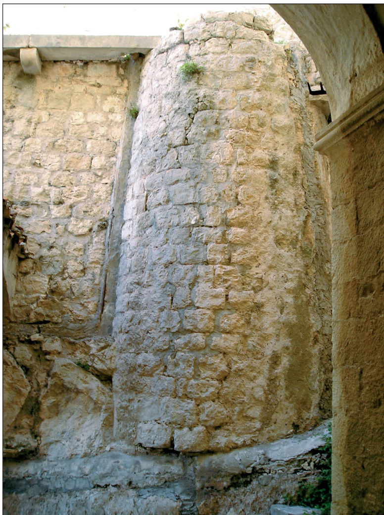
Slika 18. Taložnik unutar franjevačkog samostana
