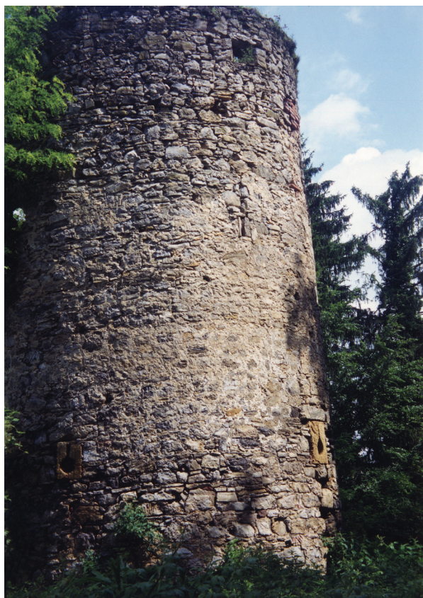
20. Novigrad na Dobri, polukula, desno uz ulaz: uočiti razne puškarnice na tri razie (Foto: Z. Horvat).
