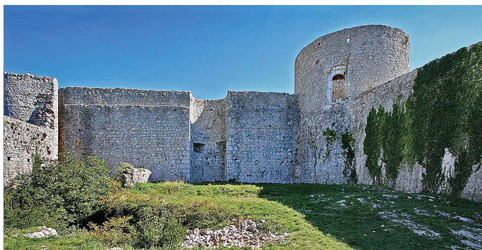
23. Kaštel Drivenik u Vinodolu, unutrašnjost (Foto: M. Kruhek).
