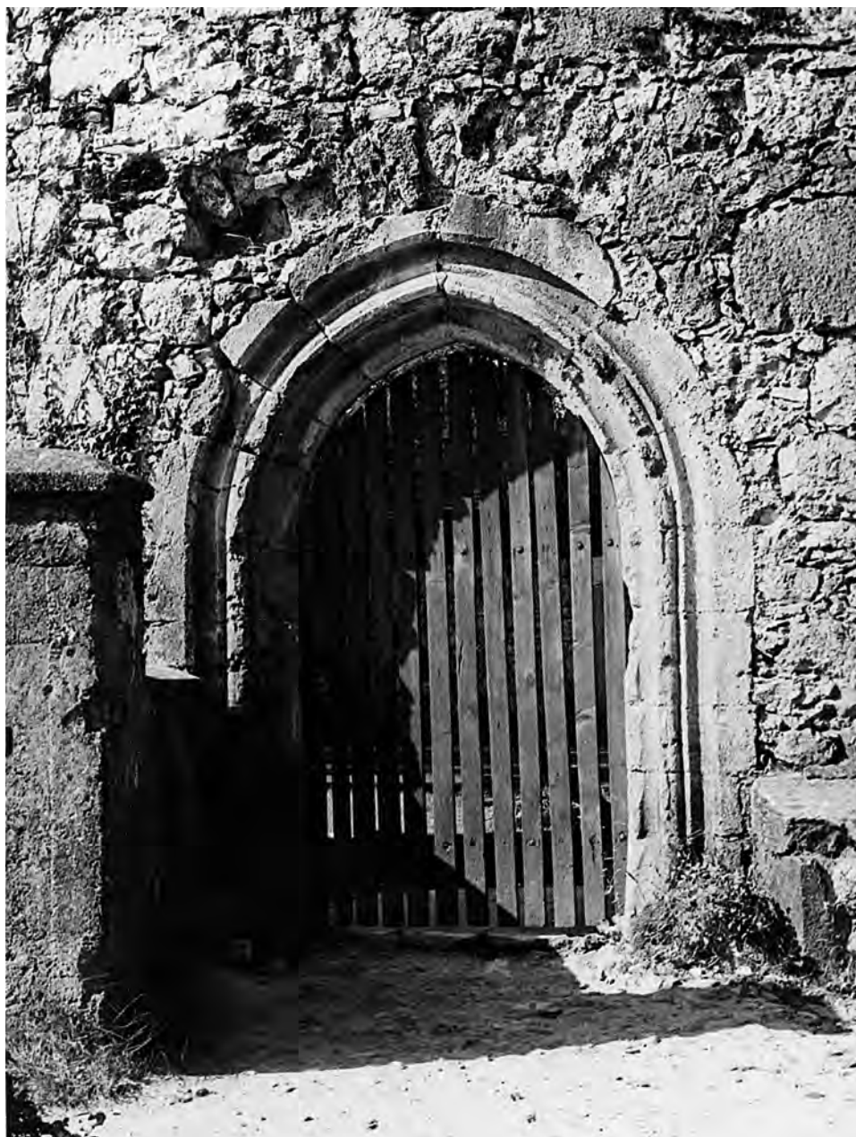
Slika 7 – Oštarije, Crkva BDM, Sjeverni portal
