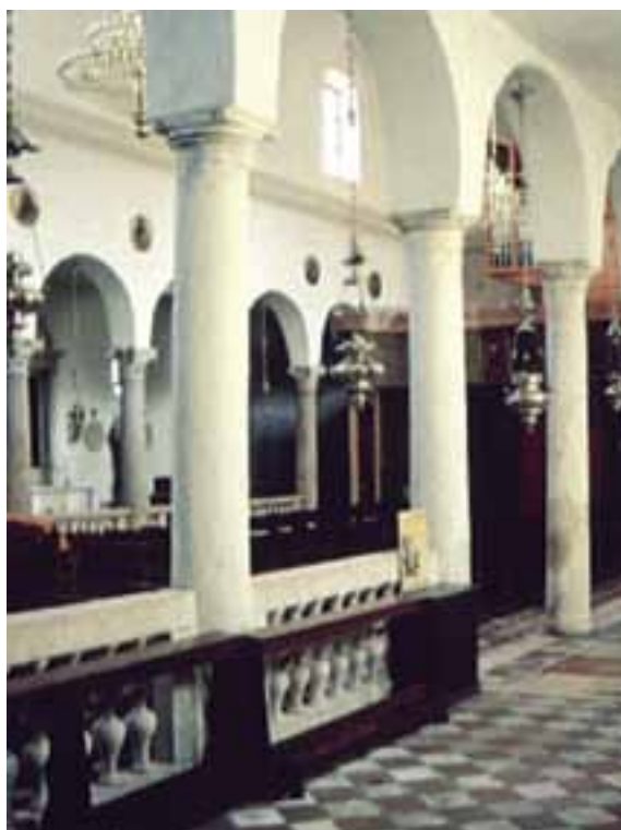
Sl. 7. Unutrašnjost crkve sv. Šime, lijevo: južna kolonada – dorski kapiteli; desno: korintski kapitel sjeverne kolonade (preuzeto: VEŽIĆ, 2005.)
