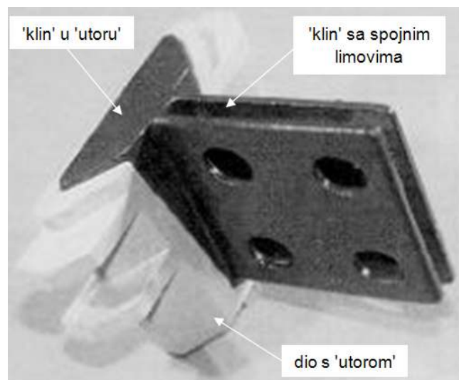
Slika 1 - Dijelovi tipičnog „ATLSS priključka“
