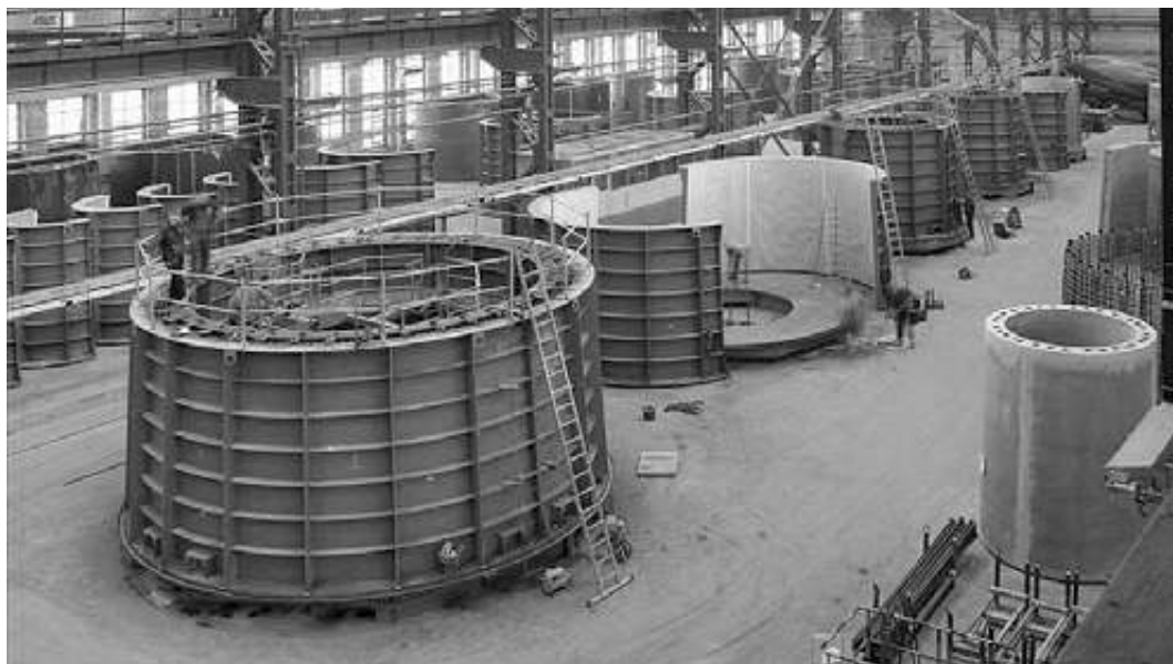
Slika 5 - Proizvodnja segmenata betonskih stupova [1]
