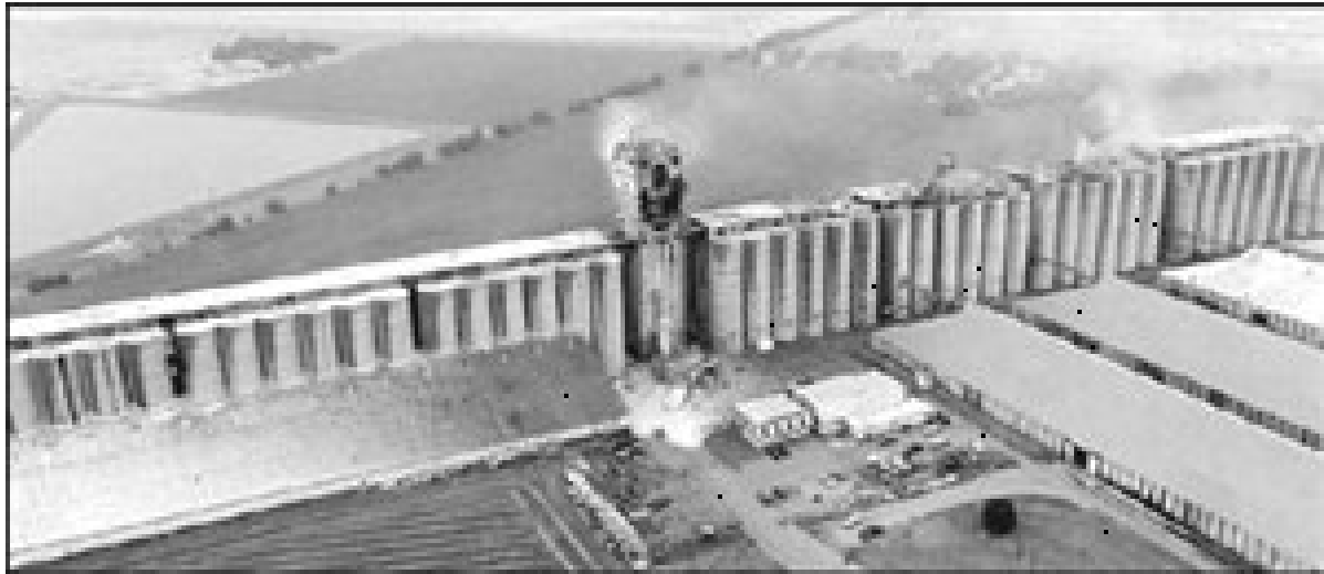
Slika 22. Primjer posljedica slučaja serija sukcesivnih eksplozija oblaka uskovitlavane prašine pljeve i inih sitnih čestica tvari biljnog podrijetla u velikom silosnom kompleksu
