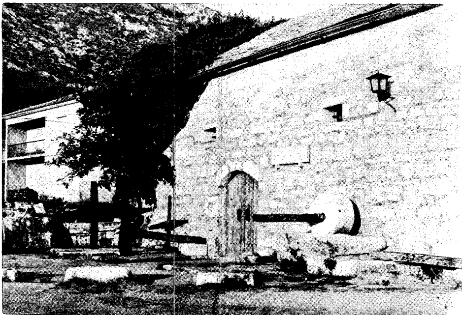
Zgrada muzeja u Gatima, desno od ulaza toč za masline, lijevo dijelovi »turnja« s »lozama« i »škrovama« (»za oturnjat, izimat drop, mast«)
