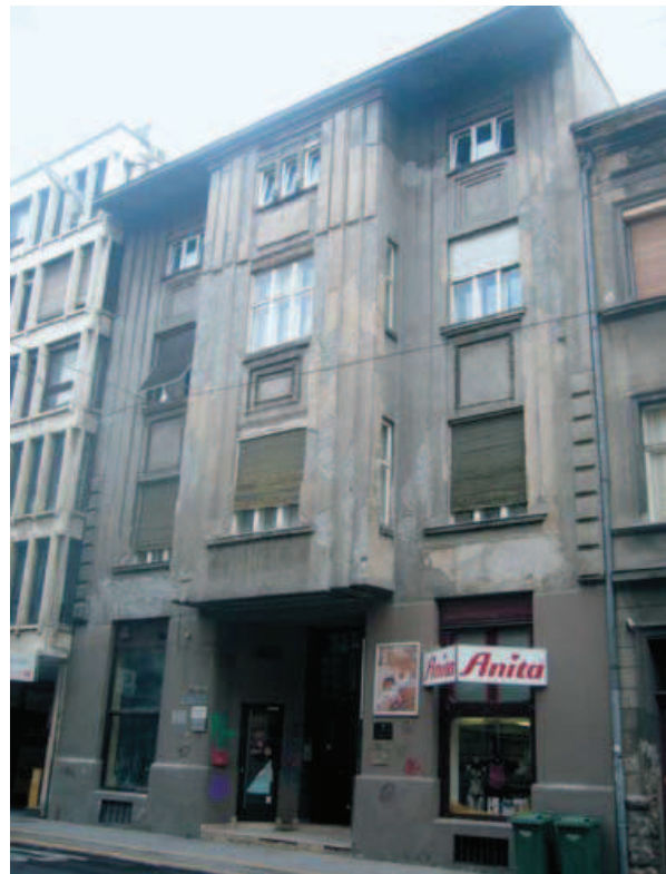
Slika 7. Zgrada u čijim je podrumskim prostorijama Zbirka bila smještena od 1924. do 1931. god.
