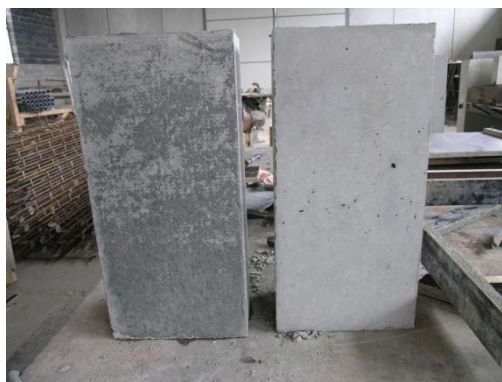
Slika 4 - Površina betonskog elementa pripremljenog u CPF oplati (lijevi uzorak) i u klasičnoj drvenoj oplati (desni uzorak)
