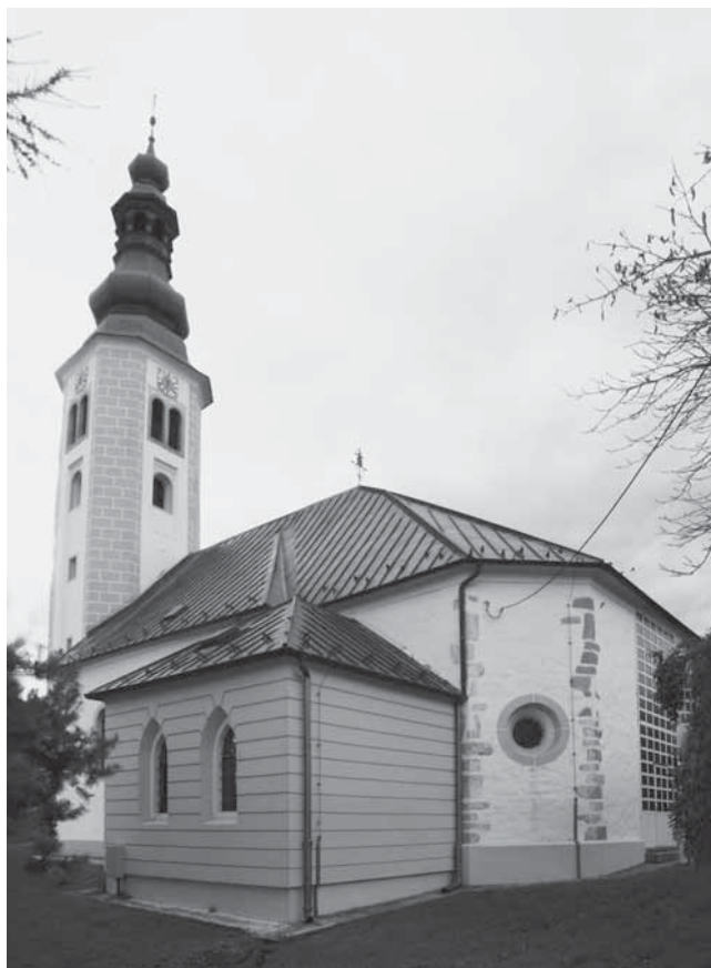
Bočno pročelje i začelje župne crkve u Markuševcu s pogledom na sakristiju, podignutu prema Bolléovim projektima 1883. (foto: D. Damjanović, 29. 8. 2010.)
