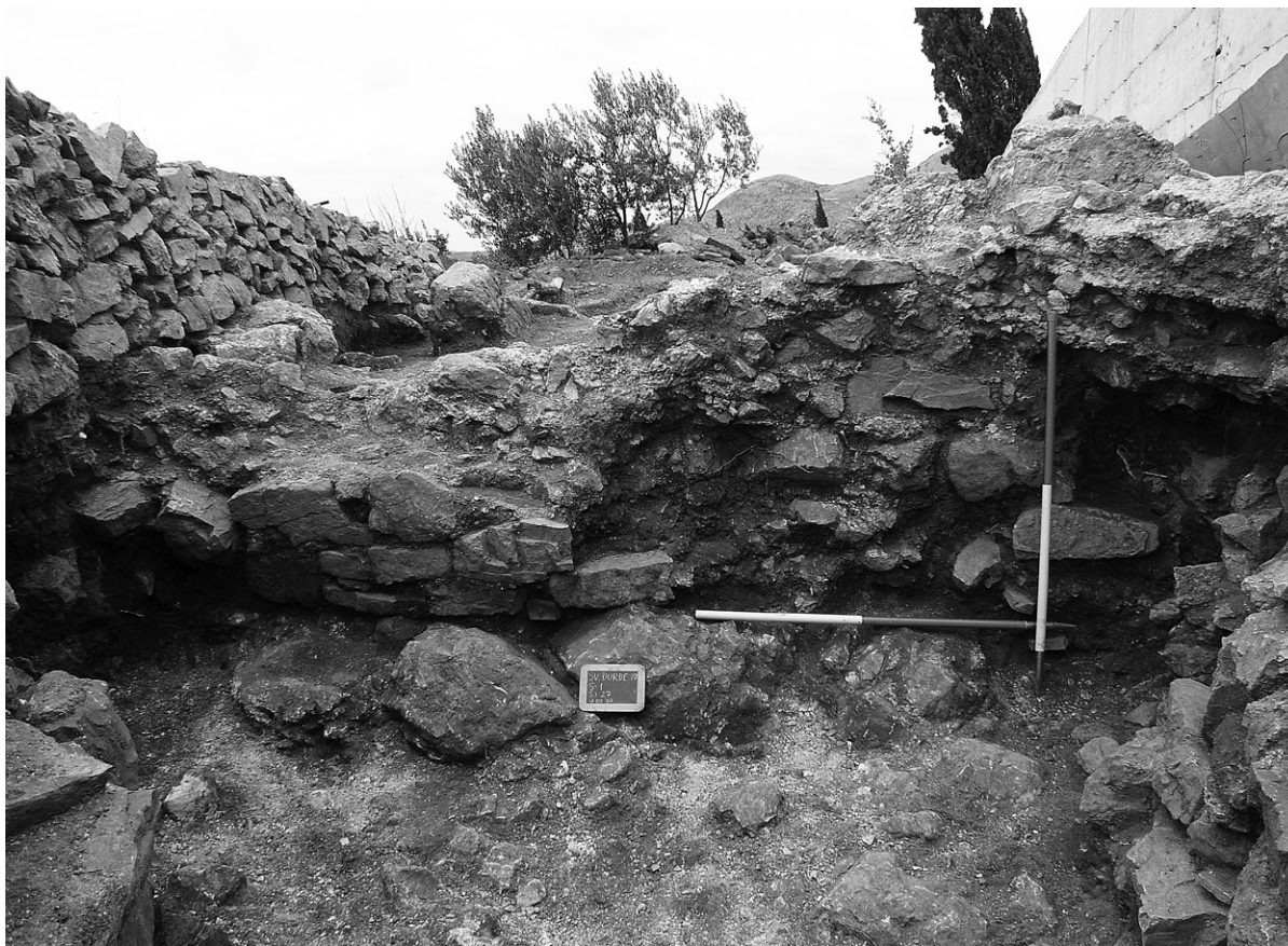
Sl. 5. Lice zida u istočnom dijelu sonde – pogled s jugoistoka (foto: M. Perkić)
