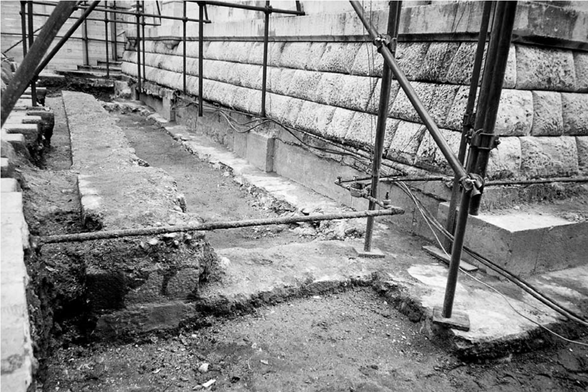
Sl. 7. Ostatci romaničke stambene arhitekture (foto: M. Mojaš)
