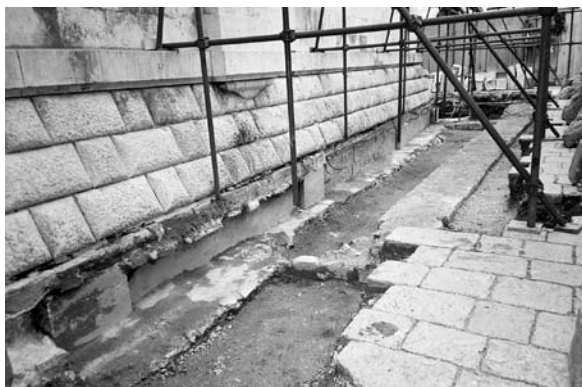
Sl. 11. Sjeverozapadni ugao crkve (foto: M. Mojaš)
