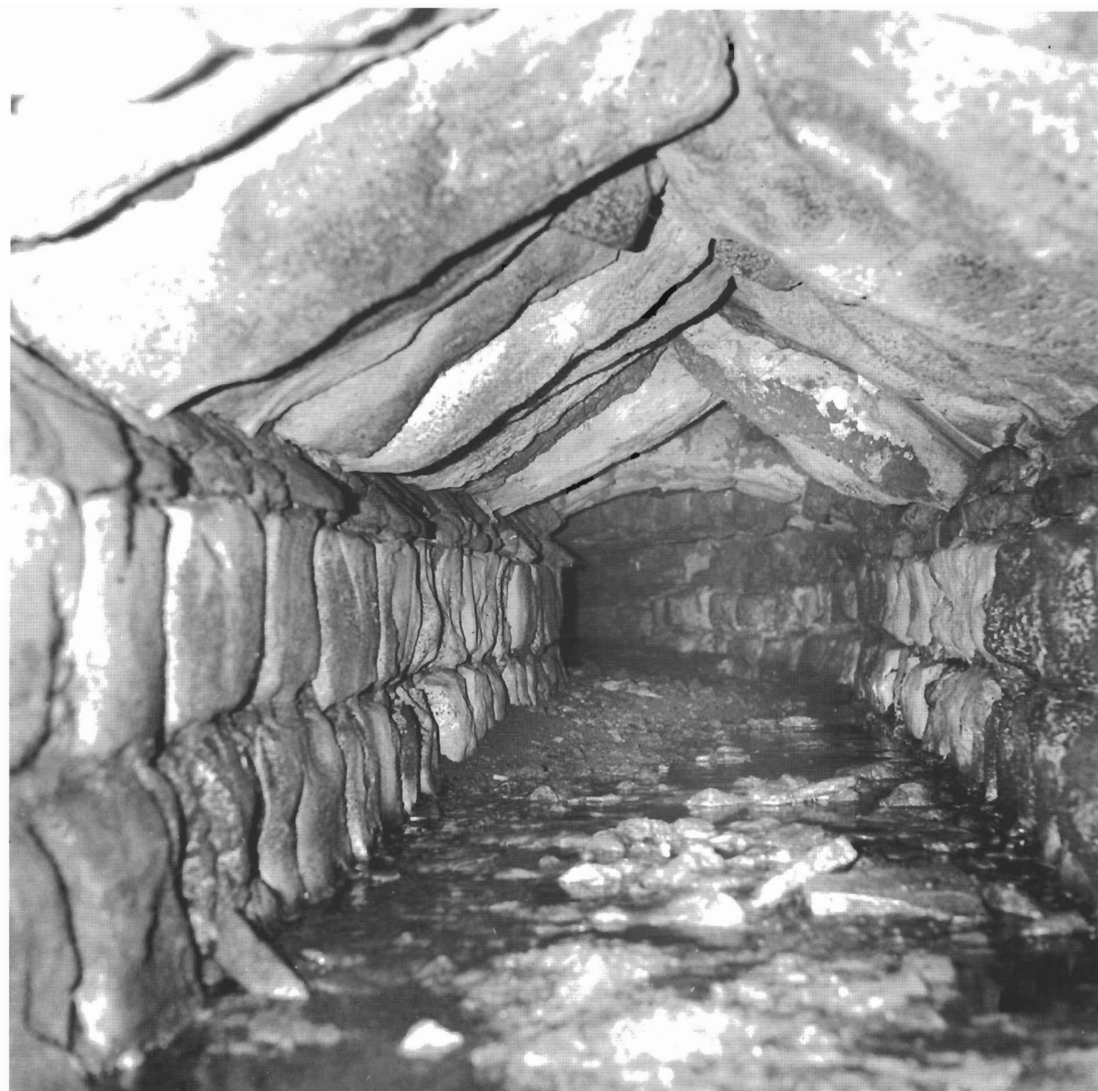
Sl. 13. Kanal kanalizacije, Držićeva poljana (foto: Miljenko Mojaš)
