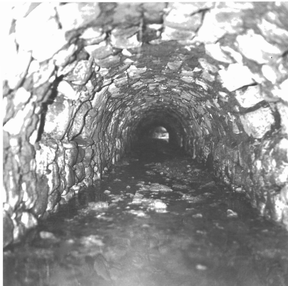
Sl. 12. Kanal kanalizacije, Držičeva poljana (foto: Miljenko Mojaš)
