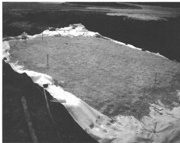
sl. 13. Konzervacija pronađenih ostataka prekrivanjem geotekstilom i šljunkom (foto: Z. Alajbeg)
