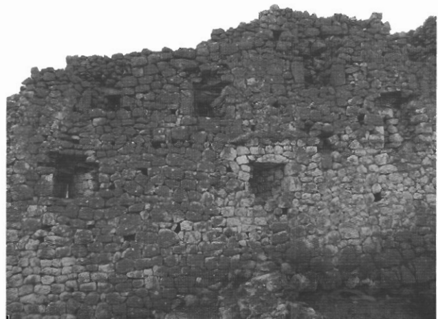
sl. 5. Otvori za grede drvenog ophoda za pristup puškarnicama
