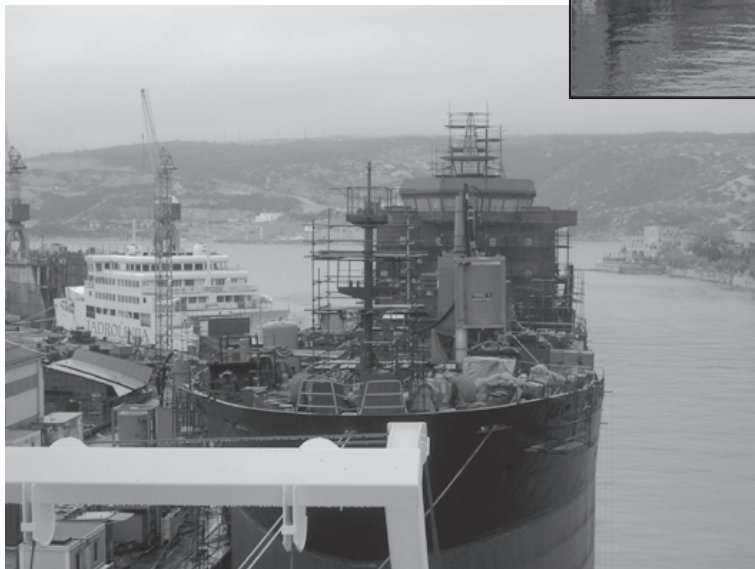
Novogradnja 532 - Asphalt Sailor u fazi opremanja
