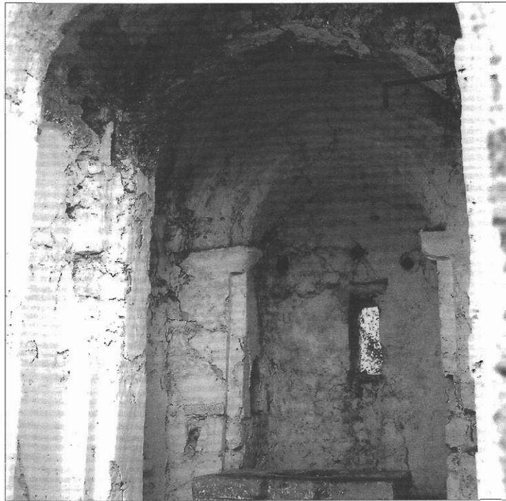
Sl. 16. Unutrašnjost crkve Sv. Ivana Krstitelja na Lopudu.
