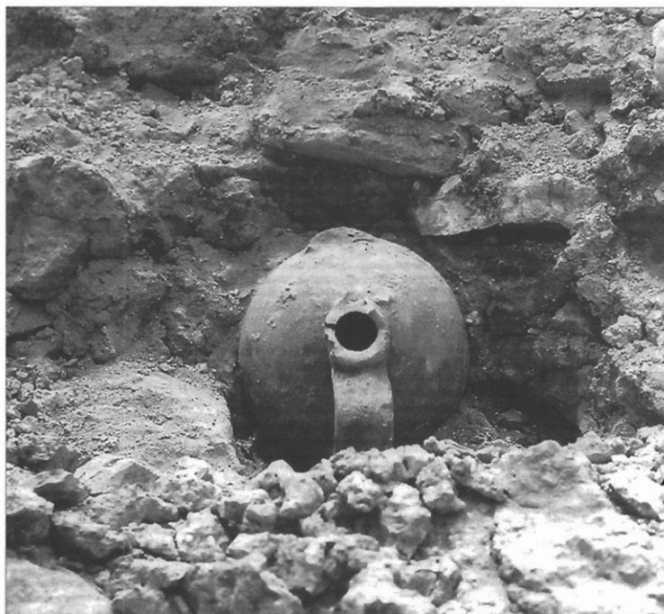
Sl. 17. Amfora, ugrađena u svodu crkve Sv. Ivana u Šilovu selu na Šipanu.
