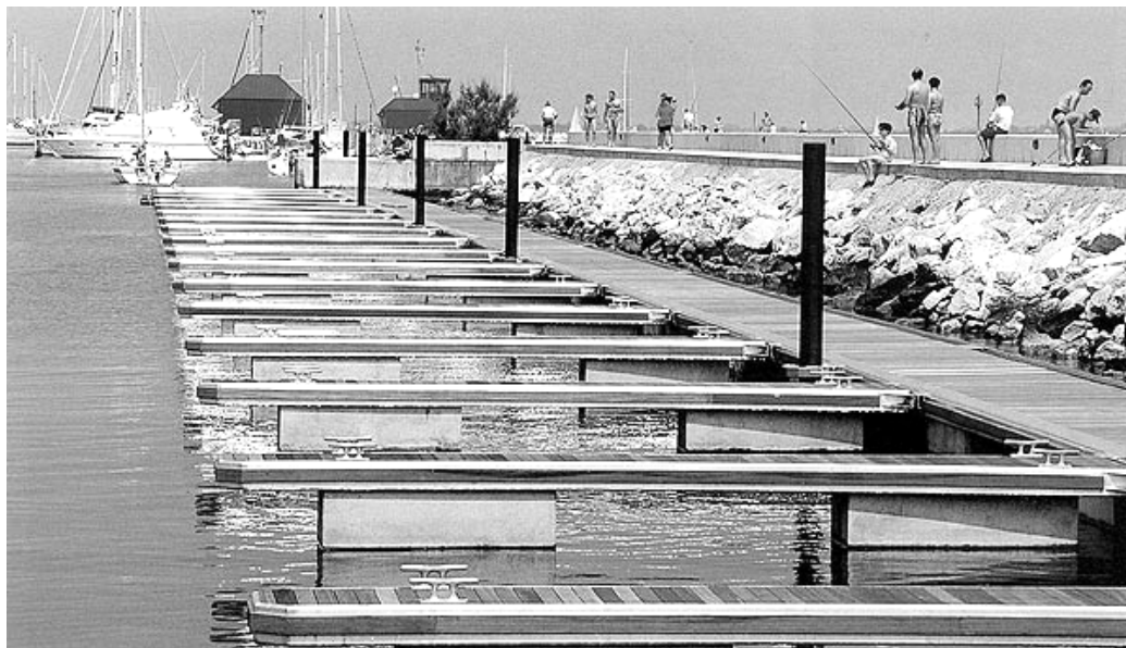
Slika 2. Pontonsko privezište uz gradski lukobran - Marina Punta Faro, Lignano Figure 2. Pontoon Berths Near City Pier – Marina Punta Faro Lignano
