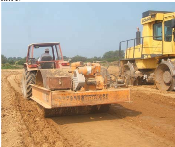
Slika 3. Prijelaz valjka preko zemljane ispunje
