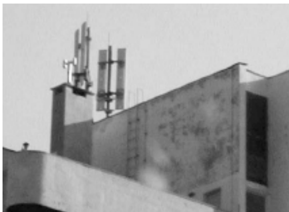
Slika 11. Antenski sustav GSM bazne postaje na vrhu zgrade
