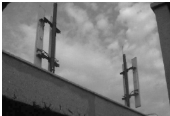
Slika 12. Pogled na dva sektora antenskog sustava bazne postaje
