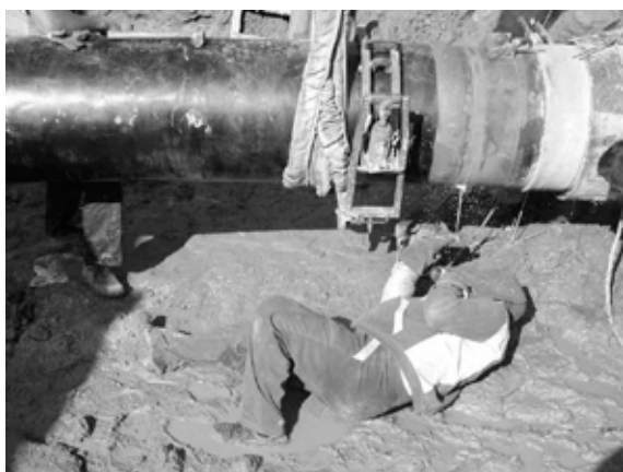
Slika 2. Primjer REL spajanja
