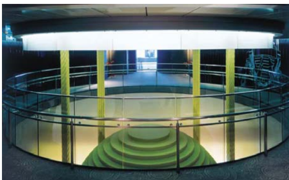
Slika 3. Pasivni dinamički prigušivač na neboderu Taipei 101 (kugla teška 730 tona) [4]
