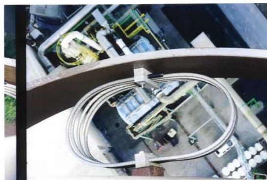
Slika 6. Opruga kao prigušni element
