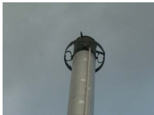
Slika 7. Prigušenje dimnjaka pomoću opruga
