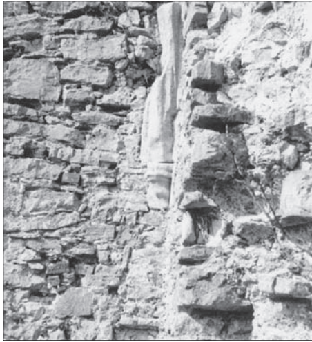
SL. 10. BURG CESARGRAD, KAPELA: KONZOLA SVODA BRODA U SJEVEROISTOCNOM KUTU BRODA
