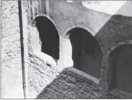
SL. 4. BURG OZALJ, ARKADE U UNUTRAŠNJEM DVORIŠTU FIG. 4. BURG OZALJ, ARCADES IN THE INTERIOR COURTYARD
