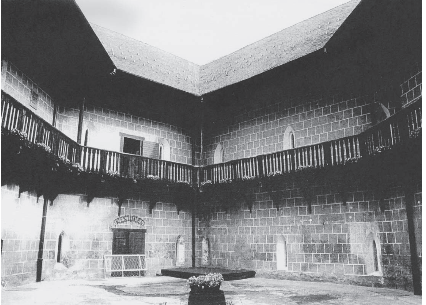
Sl. 1. Đurđevac, nedavno obnovljena dvorišna pročelja i galerija na 1. katu Fig. 1. Đurđevac, recently renovated courtyard facades and the first-floor gallery
