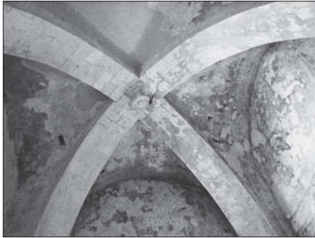
SL. 14. ZADAR, SAMOSTAN BENEDIKTINKI, DETALJ KRIŽANJA DIJAGONALNIH LUKOVA. JEDAN JE LUK GRAĐEN KONTINUIRANO, A DRUGI SE SASTOJI OD DVAJU KRAKOVA KOJI SE OSLANJAJU NA KONTINUIRANI LUK.
