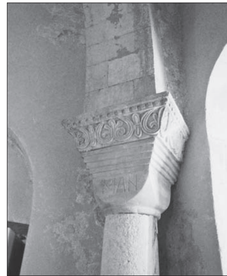
SL. 12. ZADAR, SVOD U ZVONIKU SV. MARIJE, ZIDARSKI VEZ KLESANACA MASIVNOGA DIJAGONALNOG LUKA
