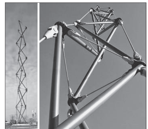
SL. 13. M. SCHLAICH: TOWER OF ROSTOCK , VISINA 62,3 M, 2003. FIG. 13. M. SCHLAICH: TOWER OF ROSTOCK , HEIGHT 62,3 M, 2003.
