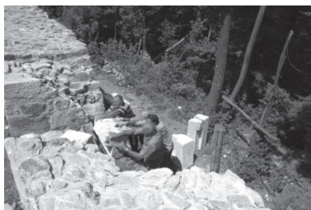
Sl. 6. Ugradnja rekonstruiranih kamenih elemenata ulaza (foto: B. Šimek)
