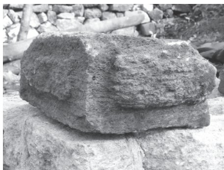
Sl. 16. Jastučasti ugaoni kamen – Buckelquader (foto: B. Šimek)
