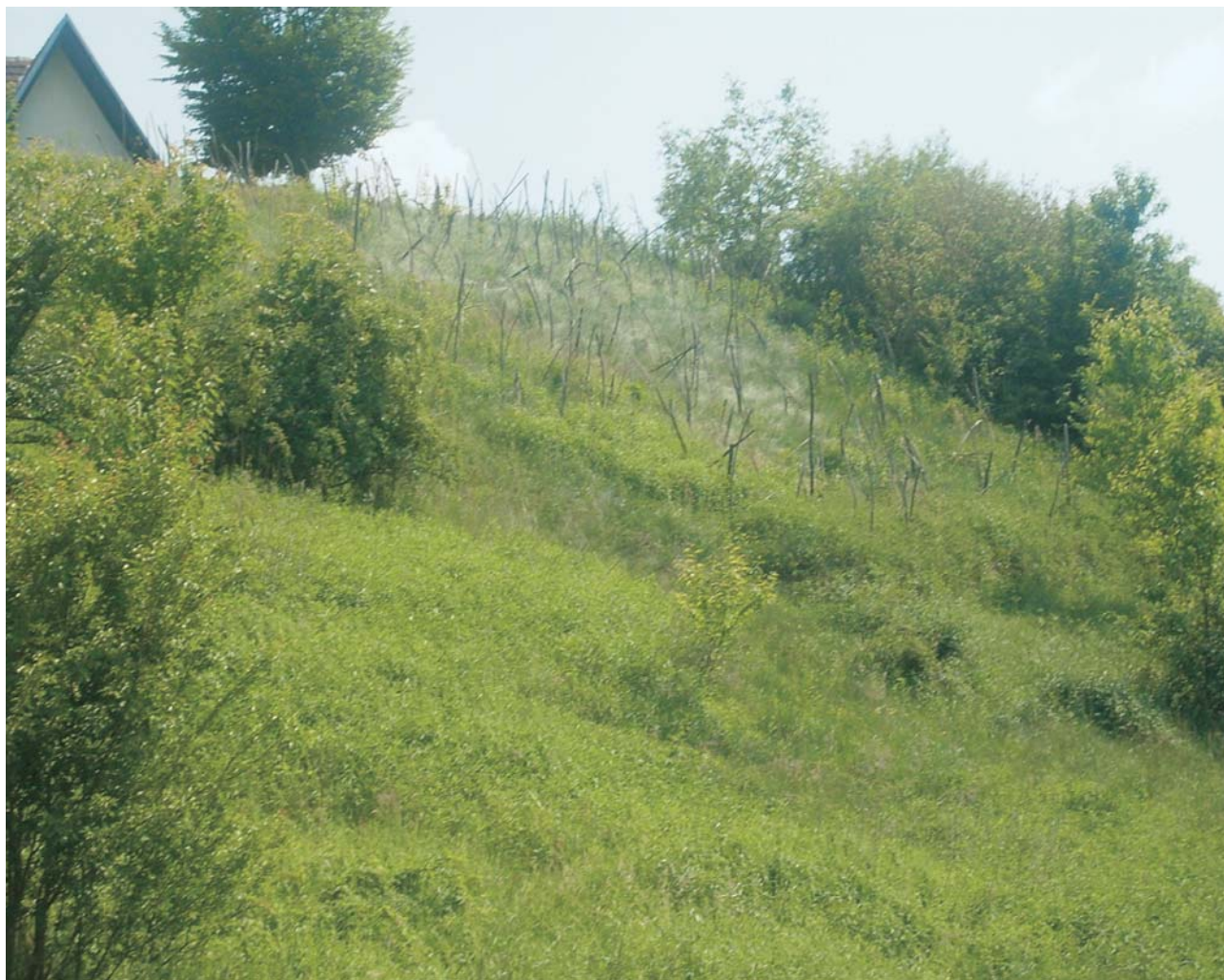
Sl 2. Primjer tepih klizišta u mjestu Crkovec Fig. 2. Example of a layer landslide at Crkovec
