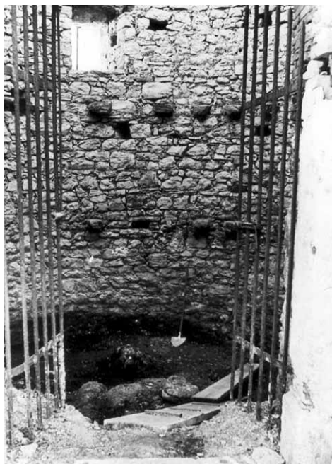
Slika 8 – Temeljenje kule na kamenu živcu, 1997., foto D. Krizmanić.
