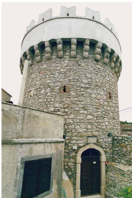
Slika 6 – Kula nakon završenih konzervatorsko-restauratorskih radova, foto N. Mavrović.
