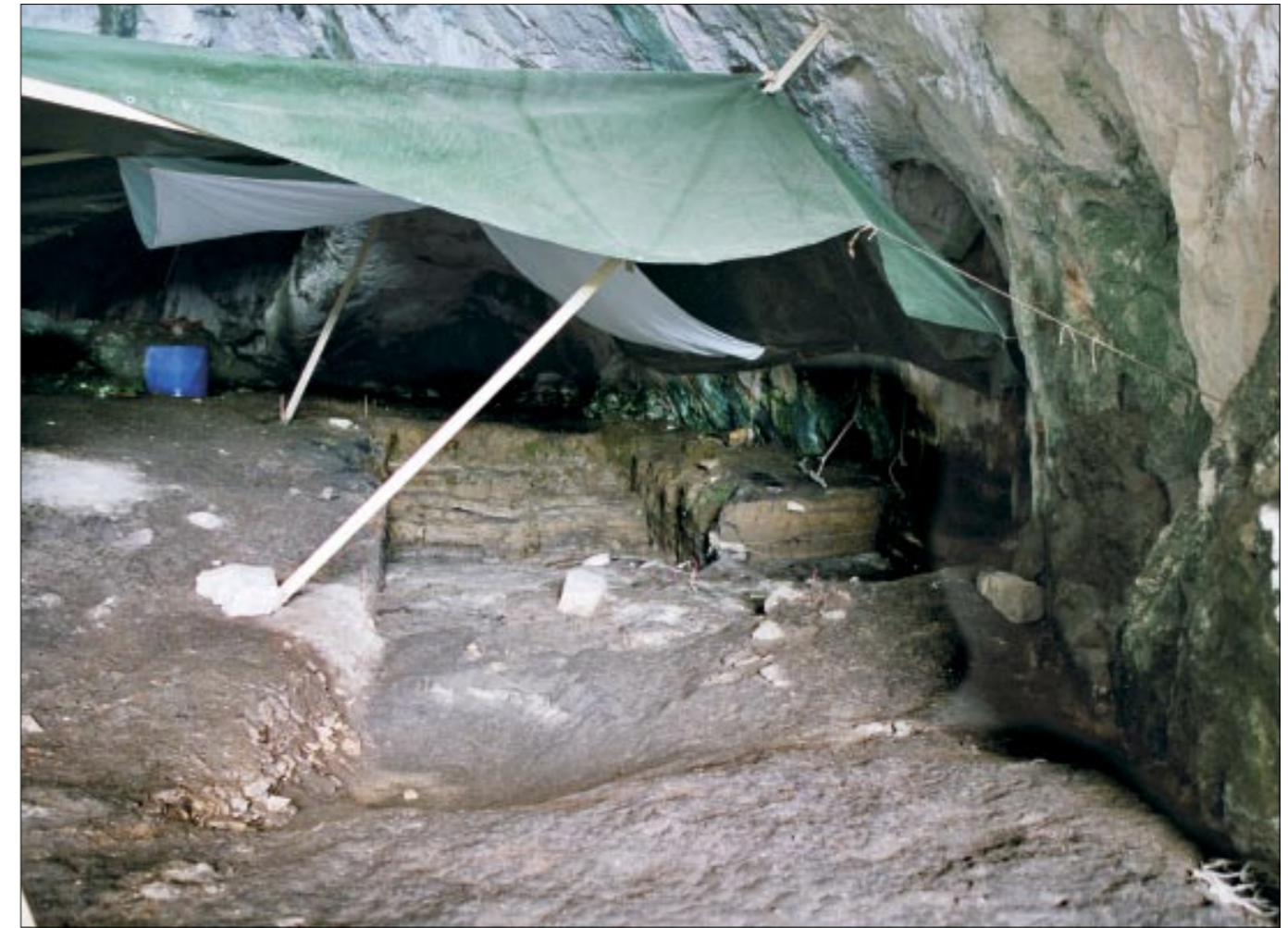
Slika 4. Konstrukcija iznad prostora sonde
