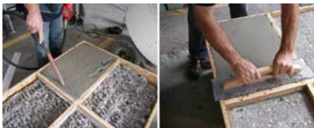
Slika 5. Ugradnja sanacijskog betona: vibriranje pervibratorom te zaglađivanje rukom
