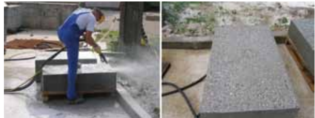
Slika 4. Obrada mlazom vode s pijeskom (pjeskarenje) gornje površine betona blokova A i B
