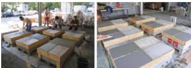
Slika 7. Svježe ugrađeni reprofilijski betoni na površinama svih 6 blokova
