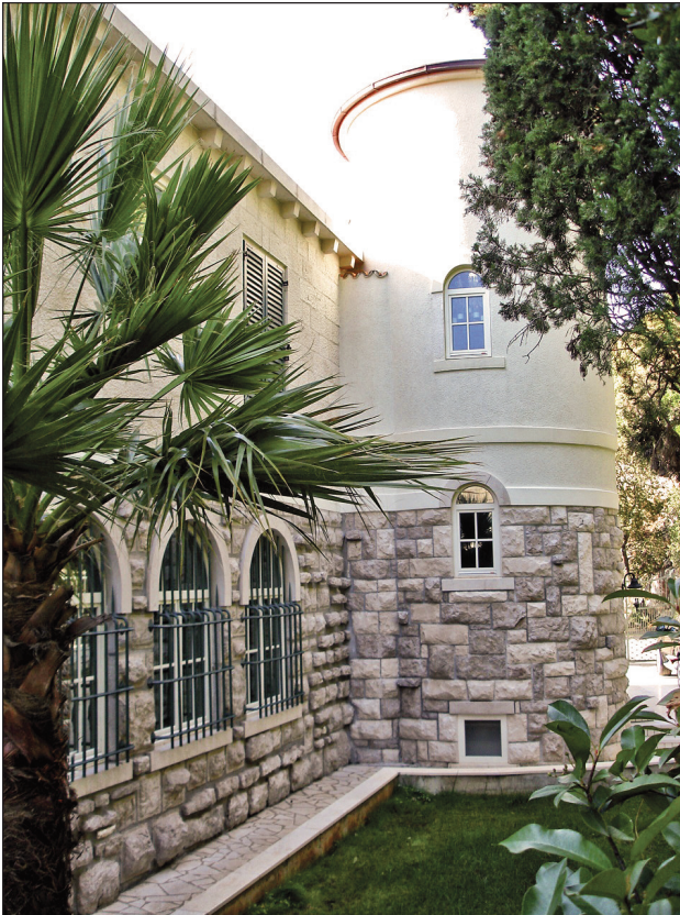
Slika 7. Vila Verčon, Lapad, 1936, detalji obrade i kružno stubište (foto: 2008)
