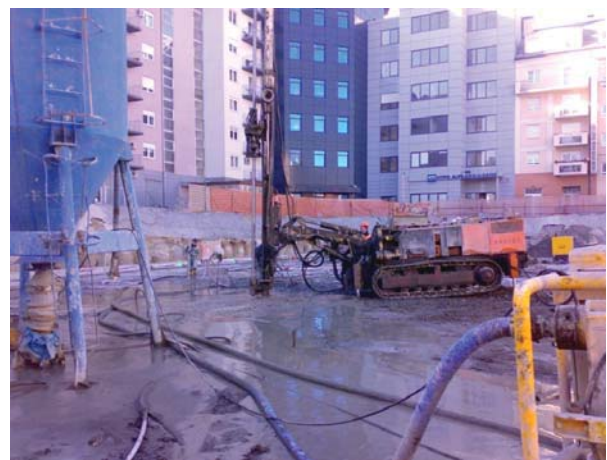
Slika 1. Pogled na građevinsku jamu uz neposrednu blizinu susjednih objekata
