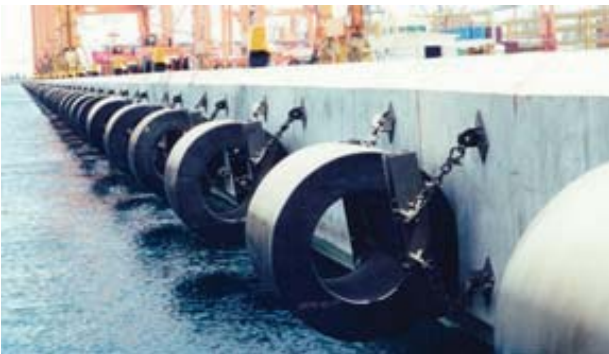
Slika 2. Primjer primjene elastičnog šupljeg gumenog odbojnika
