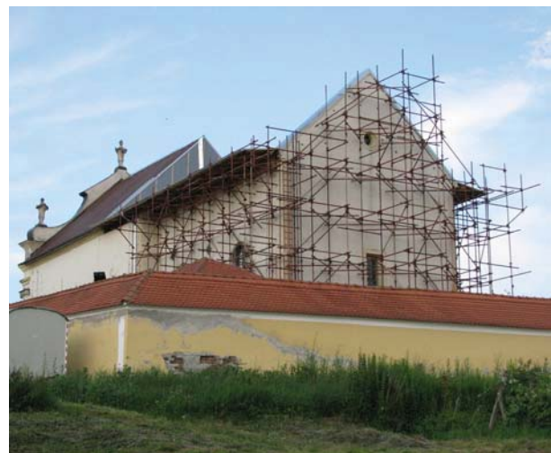
Slika 13/2. Prostorno pridržanje zidova svetišta i podupiranje trijumfalnog luka
