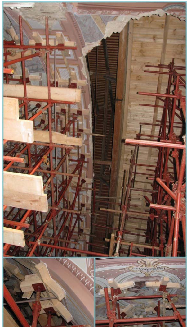
Slika 18/1. Detalji podupiranja preostalih svodova i pojasnica s ukršanim gredama
