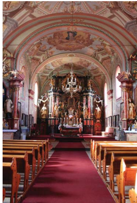
Slika 5. Unutrašnjost crkve s pogledom na svetište prije urušavanja
