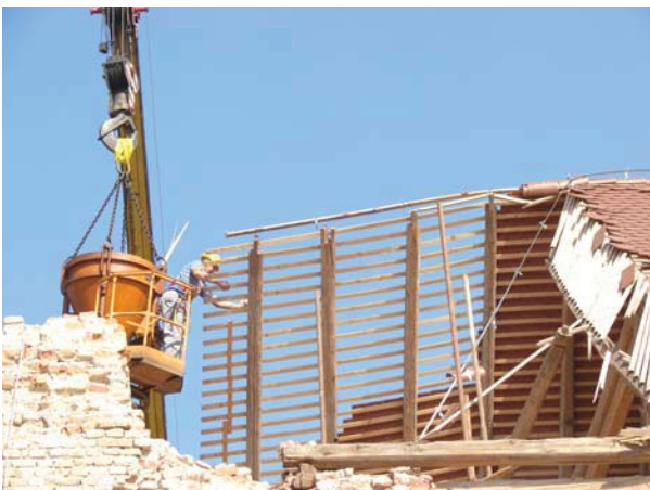
Slika 11. Rušenje oštećenih nevezanih dijelova iz sigurnosnih razloga
