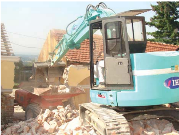
Slika 12. Mali bager i demper na odvozu urušenog materijala (oko 1000 m 3 ) na privremeni deponij
