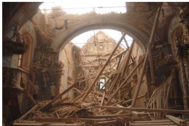
Slika 9. Urušena crkva u unutrašnjosti broda s pogledom na trijumfalni luk i svetište
