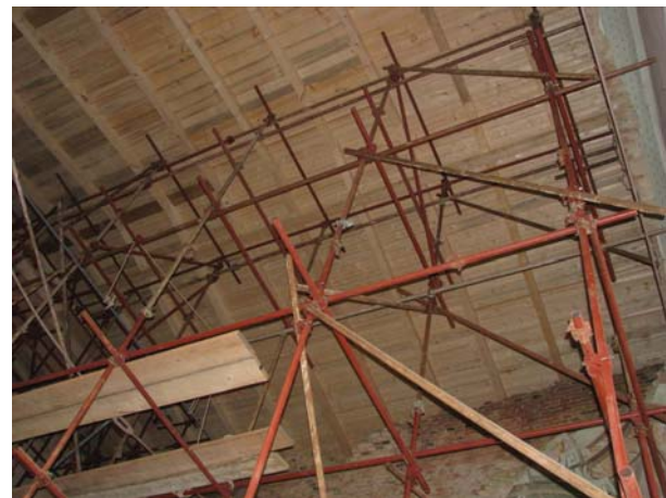
Slika 19. Cijevna skela s privremenim dvostranim krovijem (na mjestu srušenog krova i svodova)
