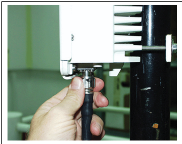
Slika 8. Spajanje koaksijalnog kabla na sektorsku antenu
