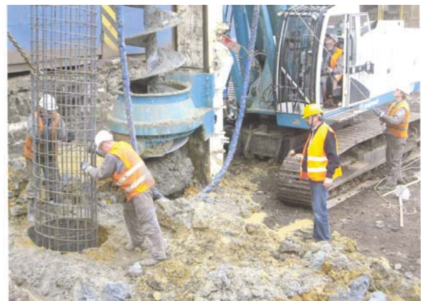
Slika 4. Ugradnja armaturnog koša
