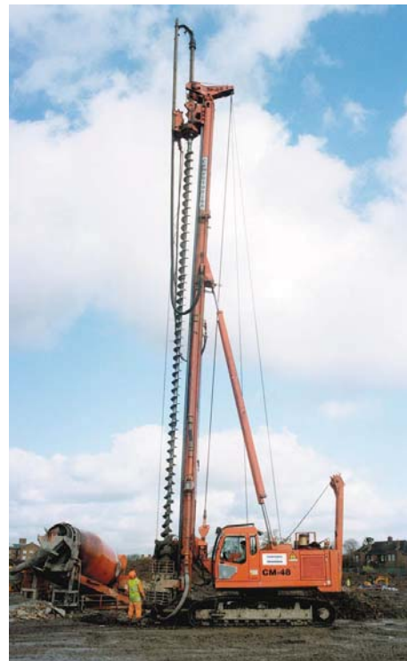
Slika 1. Bušeća garnitura za CFA pilote
