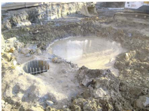
Slika 8. Izvedeni CFA piloti u tlu
