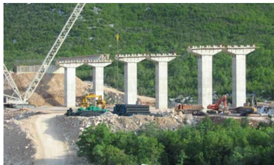
Slika 1. Montaža stupova i upornjaka
