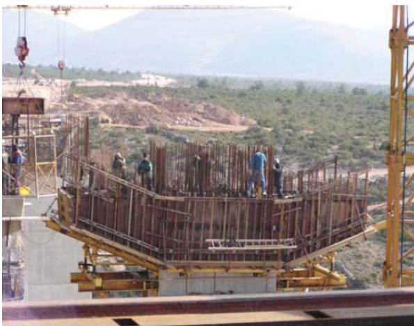
Slika 5. Izvedena skela i oplata naglavnice
