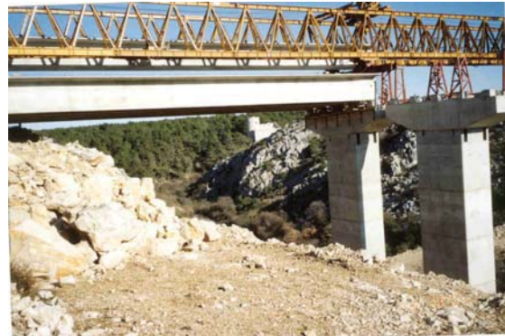
Slika 8. Montiranje glavnog nosača navlačnom skelom
