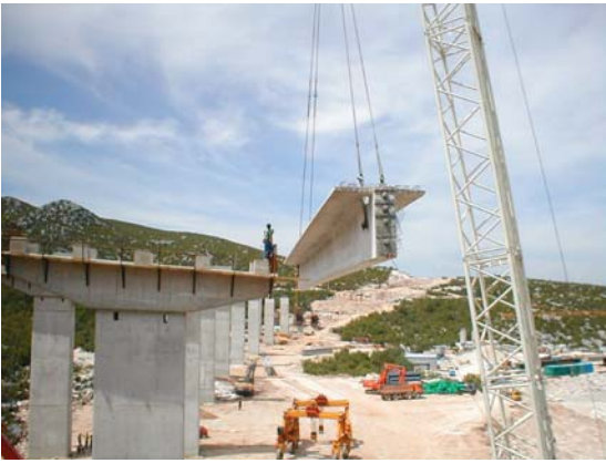
Slika 7. Montiranje glavnog nosača auto dizalicom
