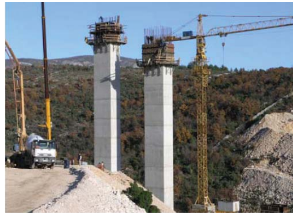
Slika 3. Izgradnja stupova za most Dabar na Jadranskoj autocesti
