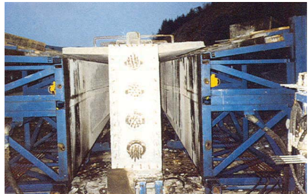
Slika 6. Izbetonirani nosač u kalupu
