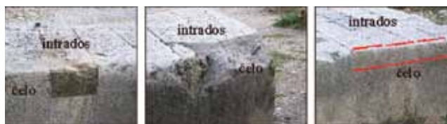
Slika 6. Neka oštećenja i sanacije na ostacima srušenog izvornog luka
