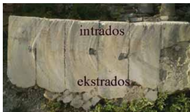
Slika 4. Ostatak kamenog luka izvornog mosta u peti, s podebljanjem iznad ekstradosa
