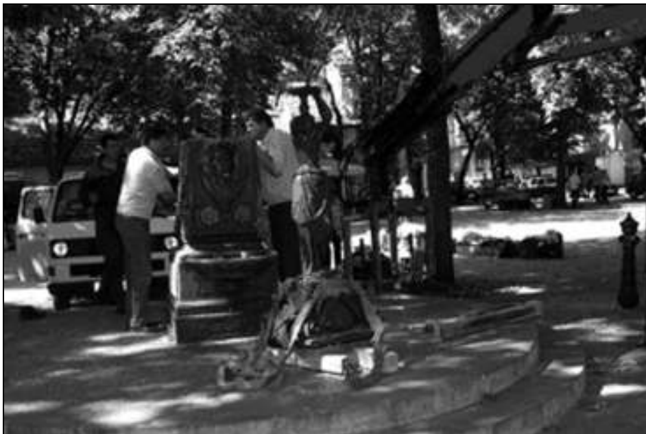
Sl. 8. Fotografija fontane u Trebinju, Bosna i Hercegovina prilikom postavljanja nakon sanacije (Fotografija preuzeta s mrežne stranice: http://www.trebinjedanas.com )
