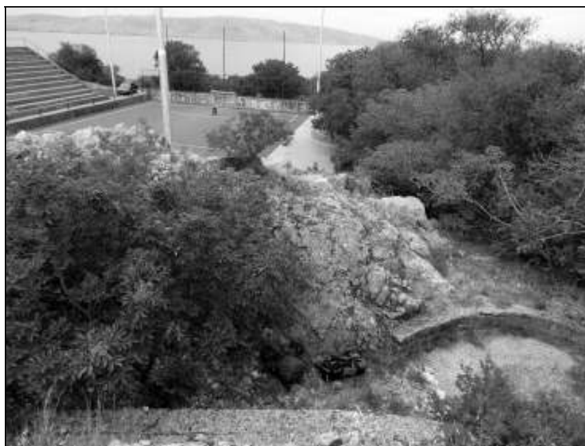
Sl. 13. Betonska ploča ispred zapadnog ulaza u bunker br. 5 (foto: Vlado Božić, 2011.)
