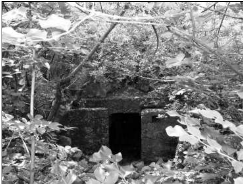
Sl. 14. Sjeverni ulaz u bunker br. 5 (foto:Vlado Binički, 2011.)
