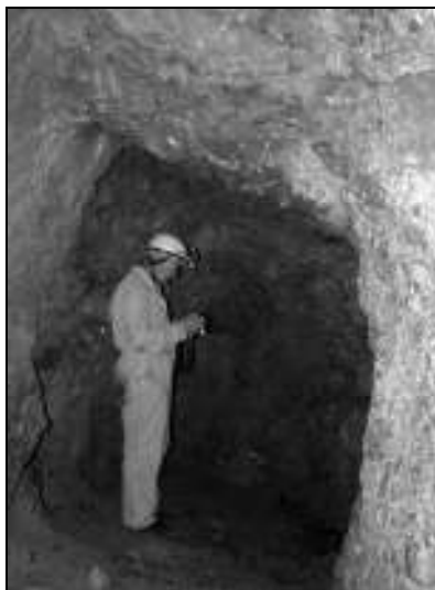
Sl. 6. Završetak bunkerskog rova (foto:Vlado Binički, 2011.)
